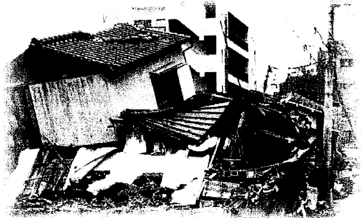
阪神・淡路大震災（平成7年1月17日発生）の被害
