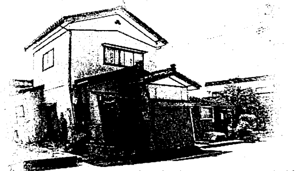
新潟県中越沖地震（平成19年7月16日発生）において、かろうじて倒壊をまぬがれた住宅
